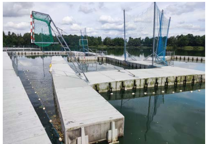
Uszkodzone pomosty UKS Set Kaniów
